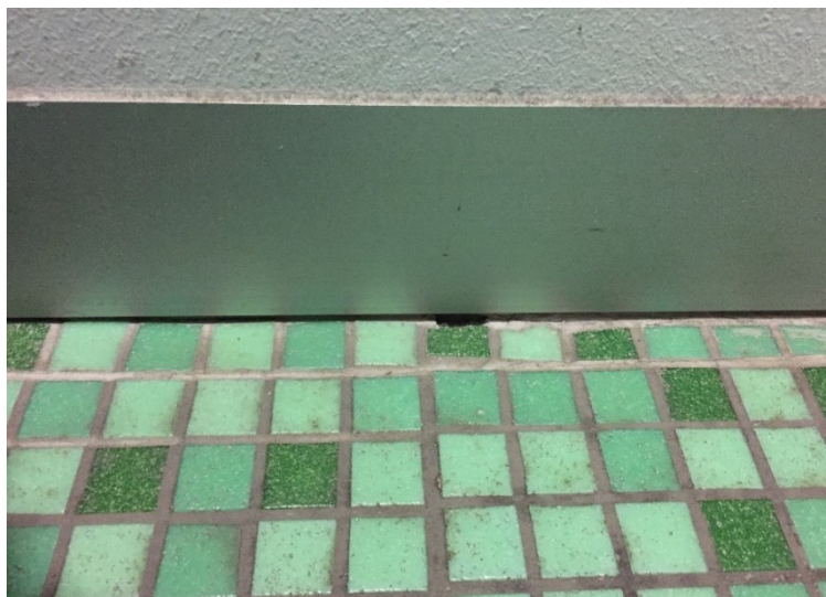
Abb. 3 Sockelleiste unverfugt, 2018, Mittweida
