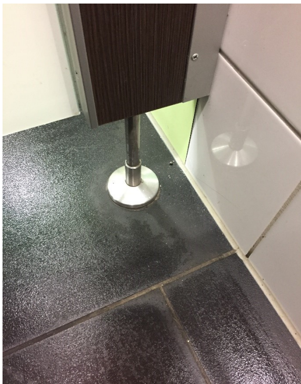
Abb. 4 Frisch gereinigter Fußboden, 2017, Chemnitz
