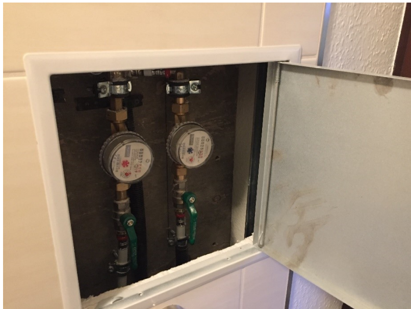
Abb. 7 Wasserzähler hinter einer Revisionsklappe, 2017, Nauhain
