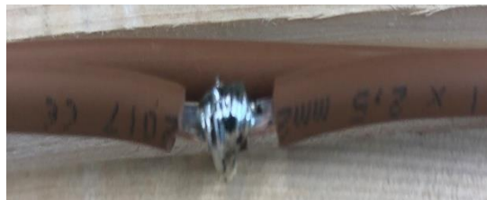
Abbildung 53: Kabel zu dem Schienen
