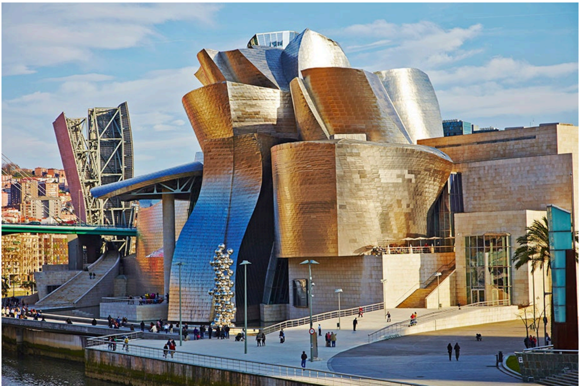
Abbildung 42: Guggenheim Museum Bilbao, Entwurf Frank Gehry, Fertigstellung 1997
