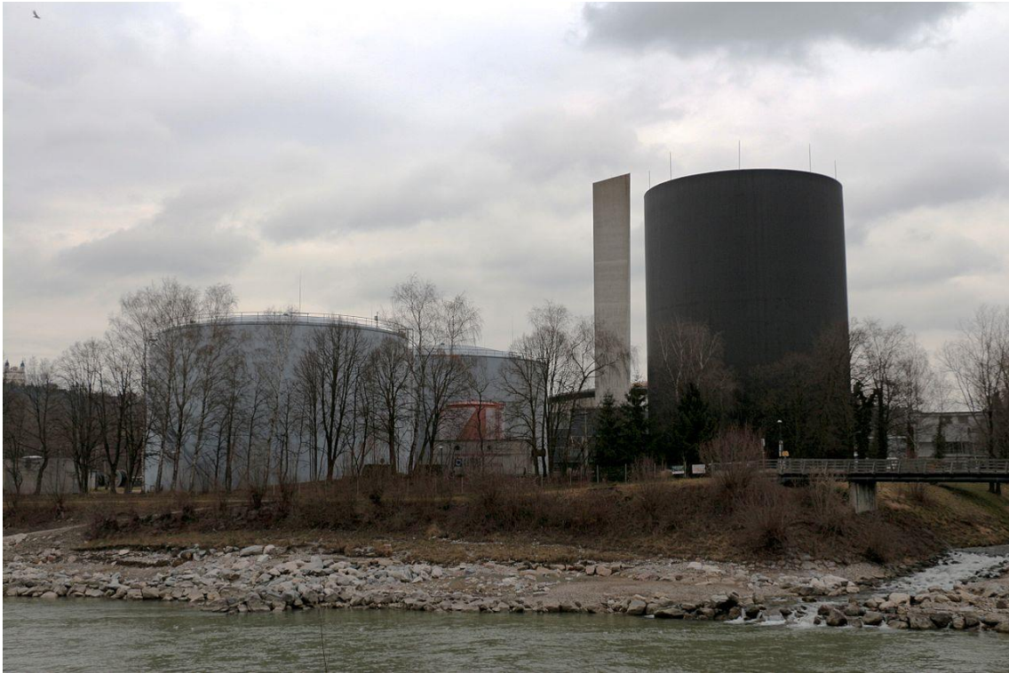
Abbildung 13 Wärmespeicher im Heizkraftwerk Salzburg Nord
