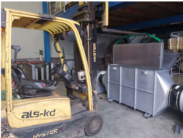
Abbildung 47 Einbringung der Kulissen mit Gabelstapler ( Quelle: ALS GmbH)
