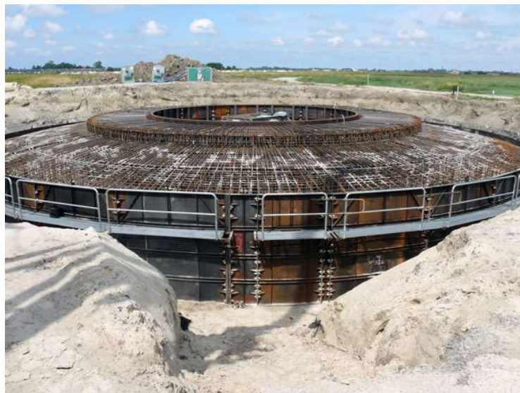
Abbildung 11 Fundament mit Schalung und Bewehrung einer WEA 109
