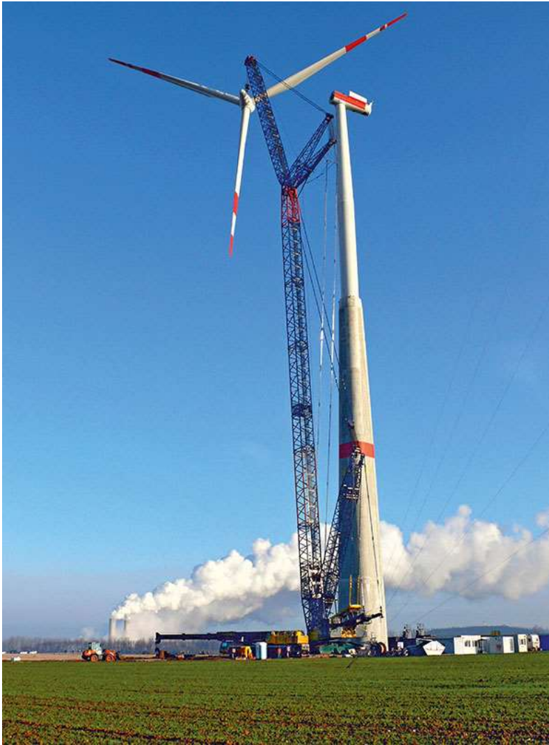
Abbildung 12 Aufstellung eines Hybridturms einer WEA 114
