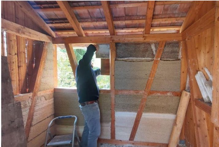
Abbildung 10 Hanffaserdämmung, Fachwerkhaus, Baden-Württemberg 244
