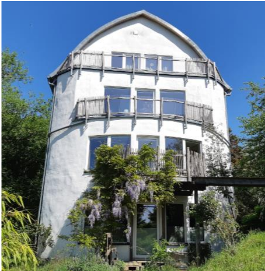
Abbildung 7 Strohdämmung, Zweifamilienhaus, Bad König 195
