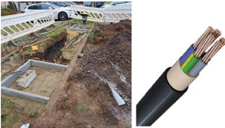
Abbildung 34: links: Profilgraben zur Verlegung von Elektrokabeln mit 2 eingebrachten Fundamenten (EMH9999); [eigene Darstellung, Dezember 2022]; rechts: Erdleitung NYY-J mit 5 Adern [75]
