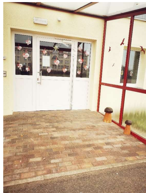
Abb. 4: Die Schwelle an der Haustür wurde entfernt und der Höhenunterschied durch eine schräge Fläche ausgeglichen (Quelle: eigene Aufnahme).
