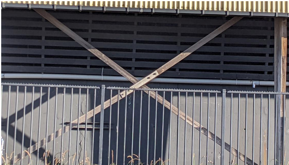
Abbildung 9: Zugverband eines Gebäudes im Industriegebiet Keileweg, Rotterdam, Niederlande, eigene Aufnahme G. Reisinger Juli 2022
