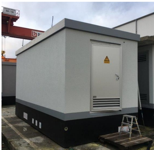
Abbildung 5.12: Beispiel einer Übergabestation
