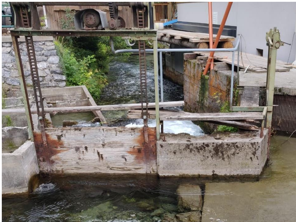
Abbildung 33: Bestehendes Hubschützenwehr
