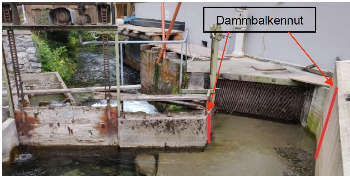
Abbildung 46: vorgeschlagene Position für die Dammbalkennuten
