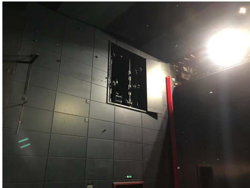
Abbildung 2: Wandvertäfelung mit Öffnung für Beleuchtungstechnik im Theatersaal (eigene Darstellung)
