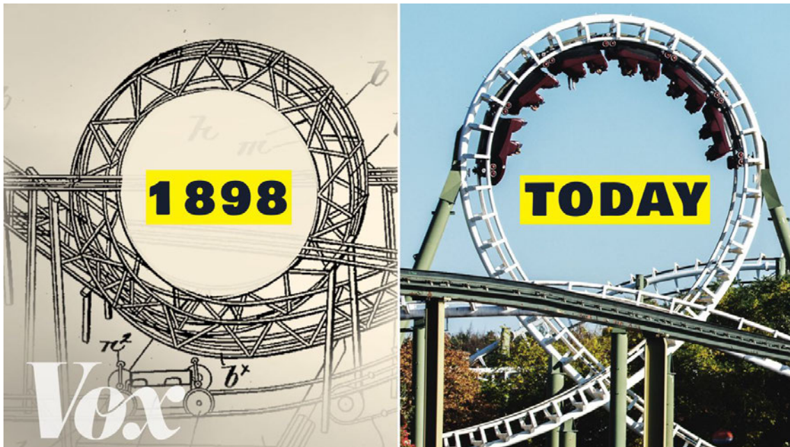
Abbildung 2.4.: Links: Der erste Looping, welcher einen perfekten Kreis beschreibt. Rechts: Der erstmals in „Revolution“ verwendete Teardrop Looping im Jahre 1976. 4
