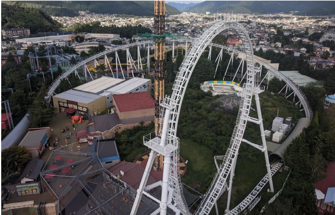
Abbildung 2.3.: Do-Dodonpa am Fuße des Mount Fuji mit dem dritthöchsten Looping der Welt (160 Fuß). Der Katapultstart ist einer der letzten, welcher mit komprimierter Luft durchgeführt wird. 3
