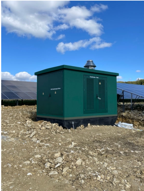
Abbildung 19: Trafostation 3150 kVA
