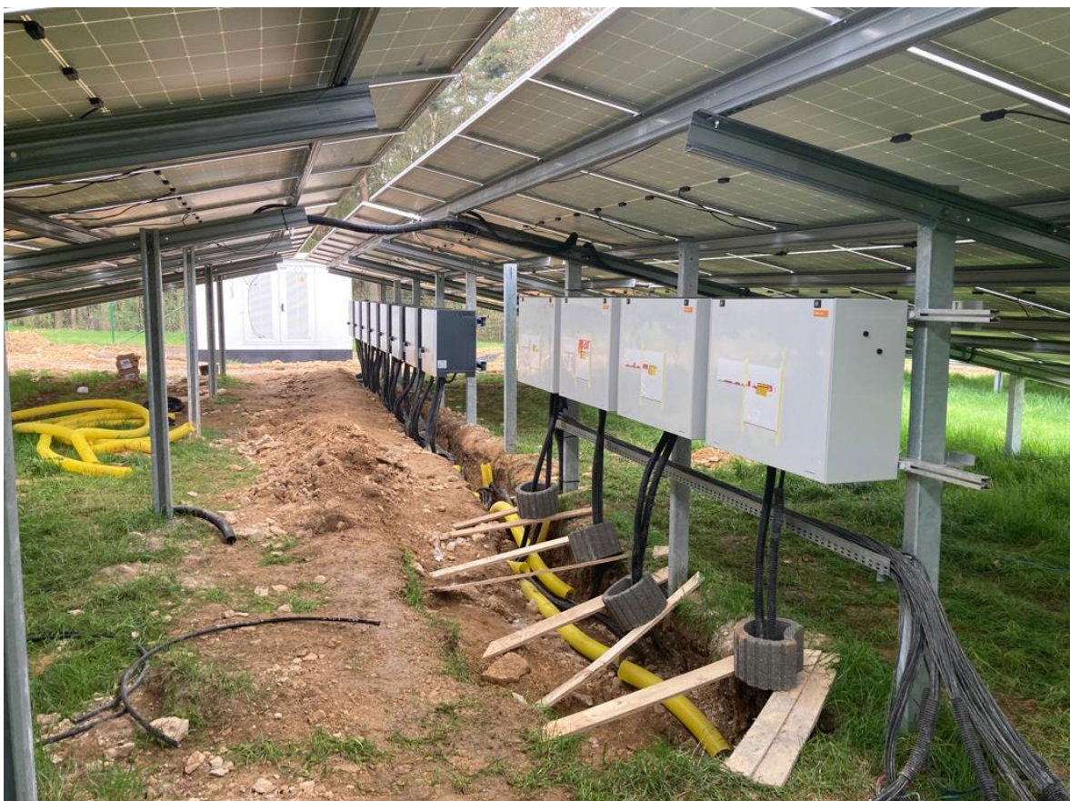
Abbildung 34: Aufbau der WR und GAK (Bildauszug aus einem anderen Projekt)
