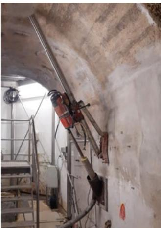
Abb. 5: Bohrlafette mit Bohrergerät im Grundablass
