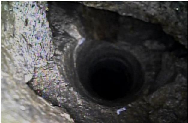
Abb. 6: SWD-Bohrung mit starken Ausbrüchen.
