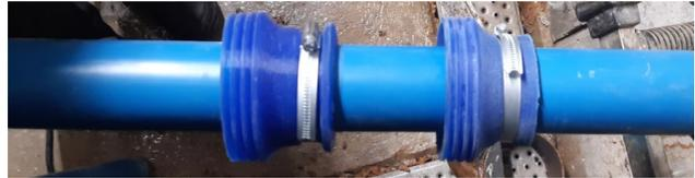
Abb. 7: Gegenfilter aus Silikon am DN50-PVC-Rohr
