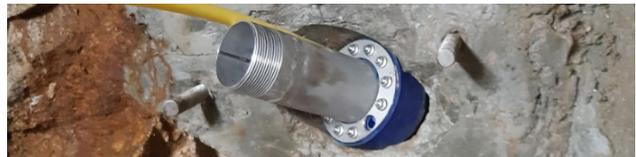
Abb. 9: Rohrendstück aus Edelstahl mit Abschlussdichtring
