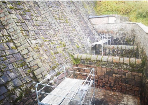
Abb. 14: Gerüste im Tosbecken während des Rückbaus der alt-Messstellen
