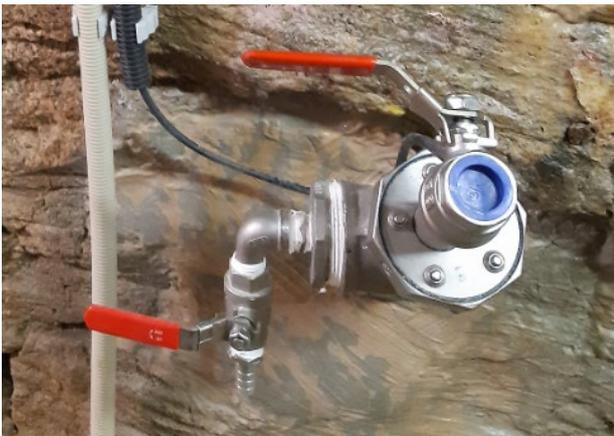
Abb. 11: Ausbauf orm einer nicht artesischen Sohlwasserdruckmessstelle mit Kugelhahn
