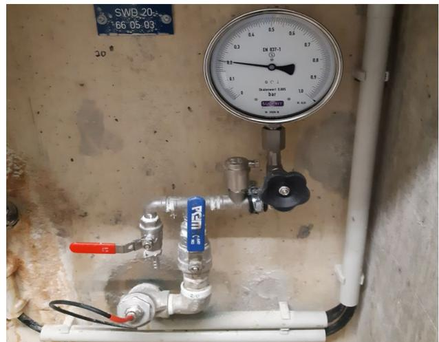
Abb. 13: verbliebene Messstelle nach der Sanierung
