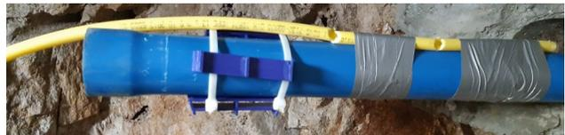
Abb. 8: DN50-PVC-Vollrohr mit Abstandhalter und Schlauch
