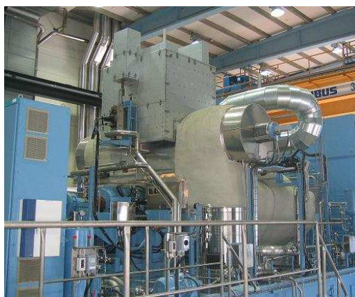
Abbildung 8.1: An der T6411 montierte Schallschutzkapsel
