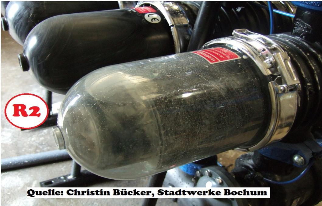
Abbildung 33: Durchsichtiges Filtermodul mit Wasser gefüllt
