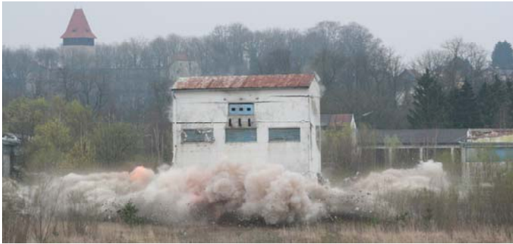
Abb. 2: Gebäudesprengung – während der Sprengung 5
