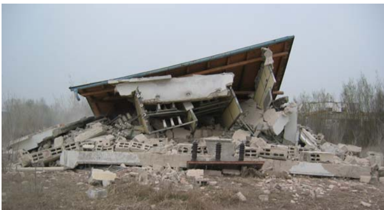
Abb. 3: Gebäudesprengung – nach der Sprengung 6
