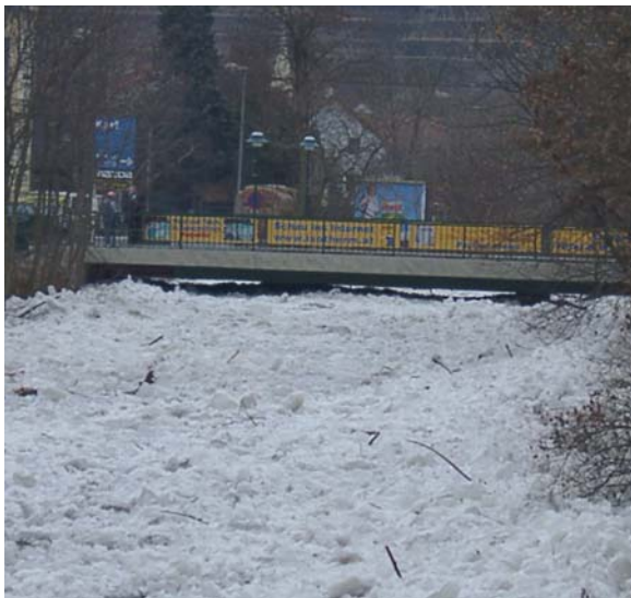
Abb. 9: Eismassen unter Brücke 12
