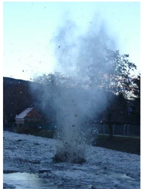
Abb. 10: Eissprengung 13
