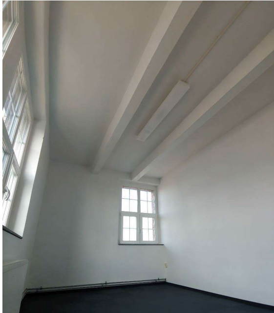
Abbildung 4: Decke mit Stahlträgern (Quelle: Eigene Aufnahmen)
