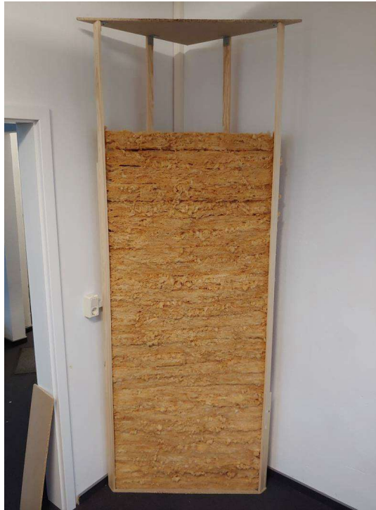
Abbildung 52: Halbfertiger Kantenabsorber (Quelle: Eigene Darstellung)
