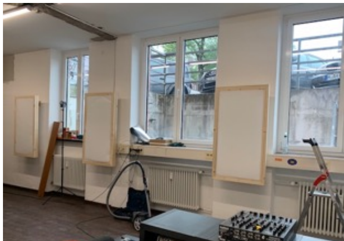
Abbildung 28: Poröse Absorber an der Wand mit Fenstern
