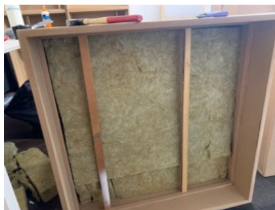
Abbildung 34: Befüllen mit Dämmstoff
