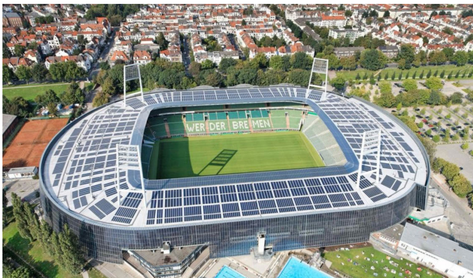
Abbildung 9: Solaranlage des Weserstadions 78
