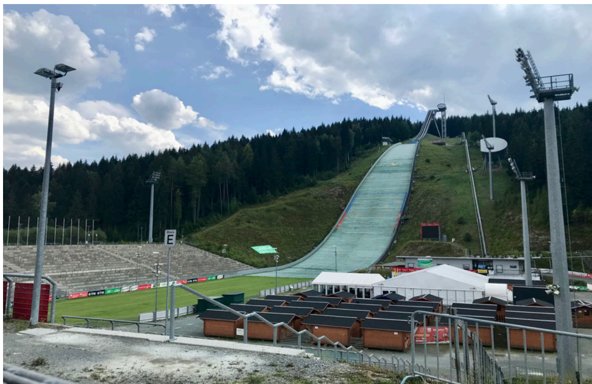
Abb. 7: Die Vogtland Arena in Klingenthal (Quelle: eigene Aufnahme)
