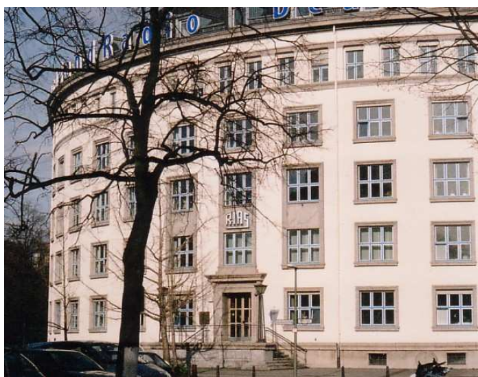
Abbildung 3: Das RIAS-Gebäude in der Kufsteiner Straße 2005 3
