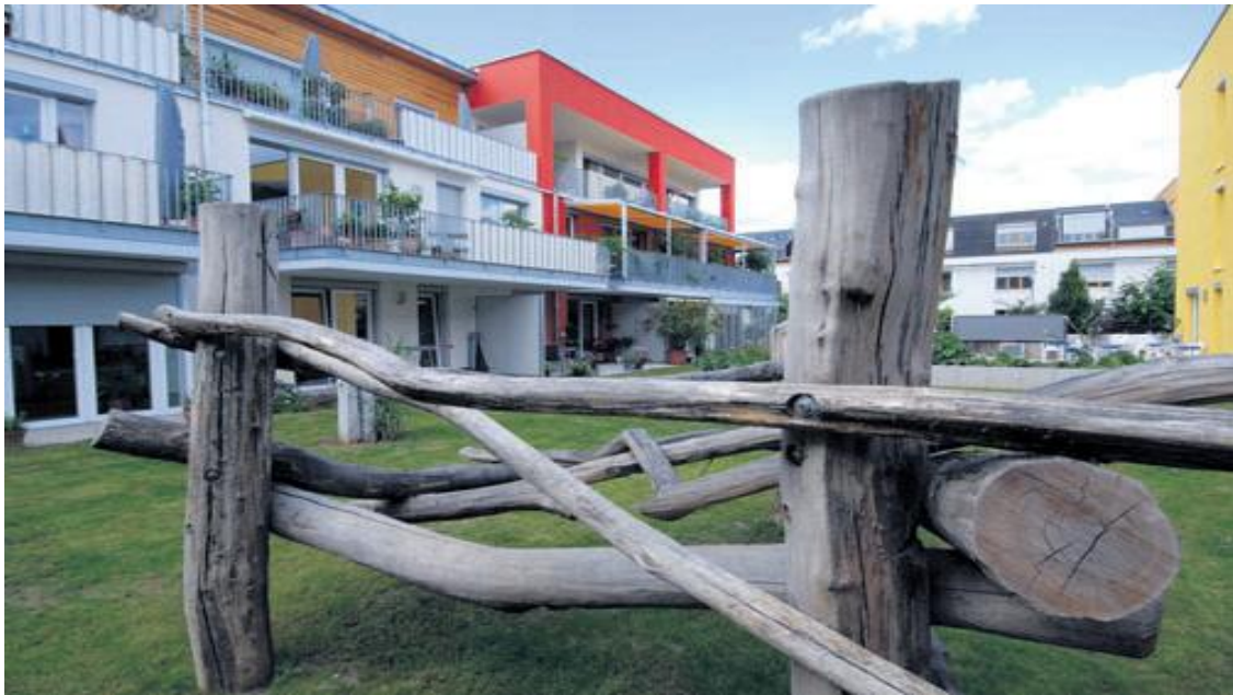
Abbildung 6: Innenhof des Mehrgenerationen Wohnprojekt Mühlbachhaus 10
