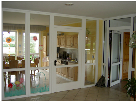
Abgetrennter Küchenbereich (Sicherheitsverglasung)
